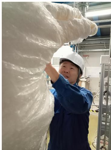
写真 1 キセノン純化装置出力ラインの除氷作業。
